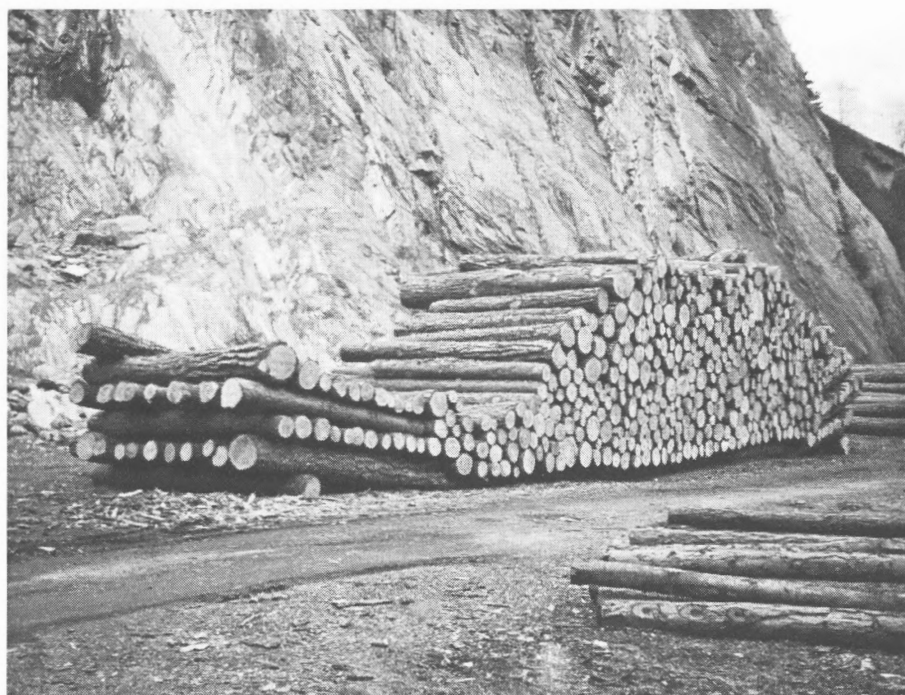
Geht fast ausschliesslich in den Export nach Italien: gelagertes Rundholz beim «Schotsch».
