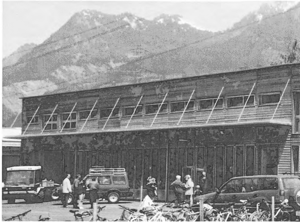
Zur Besichtigung frei und für den Bezug bereit – der neue Werkhof
