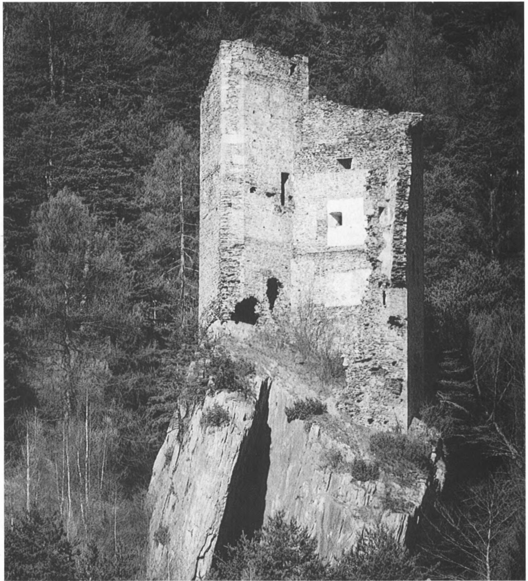
Die Ruine Haldenstein steht auf einem gewaltigen Sturzblock, dessen vordere Teile im 18. Jahrhundert herausbrachen und damit die Burg teilweise zerstörten.
