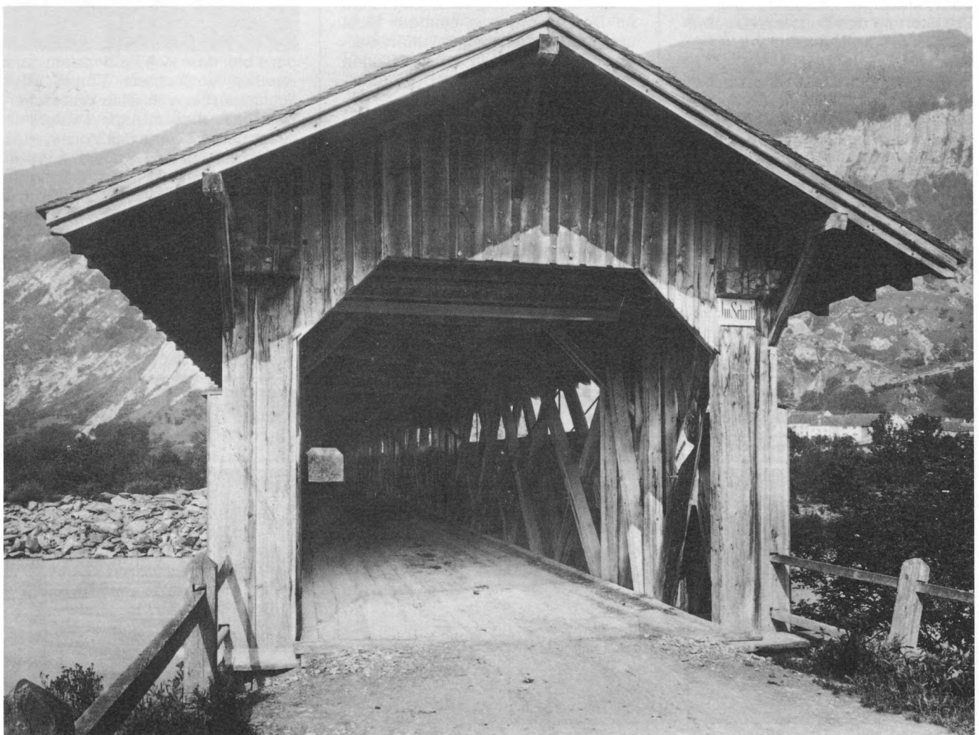
Gedeckte Haldensteiner Holzbrücke 1913. Churer Seite. Bild Kant. Tiefbauamt GR
