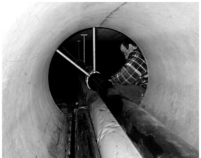
Berni Griesser bei der Reparatur der Trinkwasserleitung von Chur nach Haldenstein.
