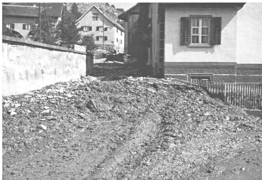
Schlammmassen beim Restaurant Adler
