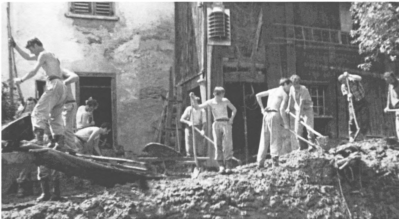
Aufräumarbeiten im Süesswingel
