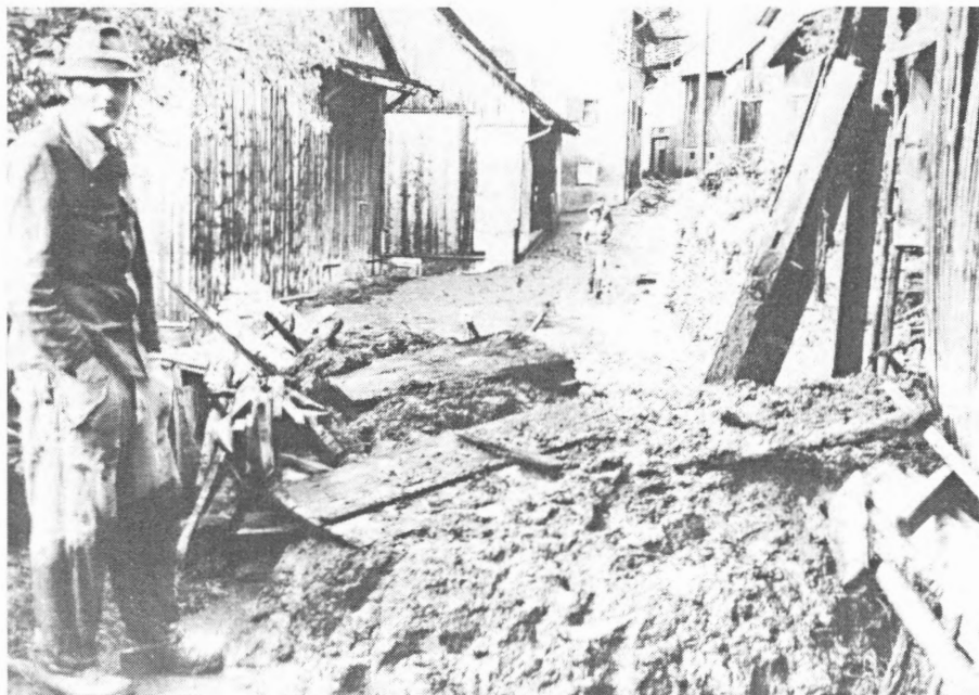
Bild der Verwüstung: Der Süesswingel nach dem Rüfenniedergang im Juli 1971.
