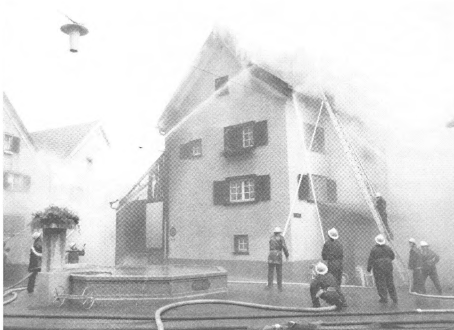
Der Stallbrand nach Blitzeinschlag auf dem Dorfplatz. Das Feuer im Stall breitete sich rasend schnell aus und drohte, auf den Dachstock des angebauten Wohnhauses überzugreifen. Die Haldensteiner Feuerwehr, unterstützt von der Churer Feuerwehr, konnte das Feuer rasch unter Kontrolle bringen. Die Einsatzleitung der Haldensteiner Feuerwehr lag bei Kurt Müller, nachdem sowohl der Kommandant als auch sein Stellvertreter in den Ferien weilte.
