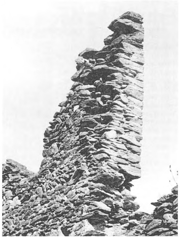
Exponierter Mauerzahn auf Lichtenstein.
