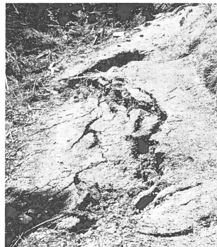
Nach der Brücke Calfetschenbach ist der Weg abgerutscht.
