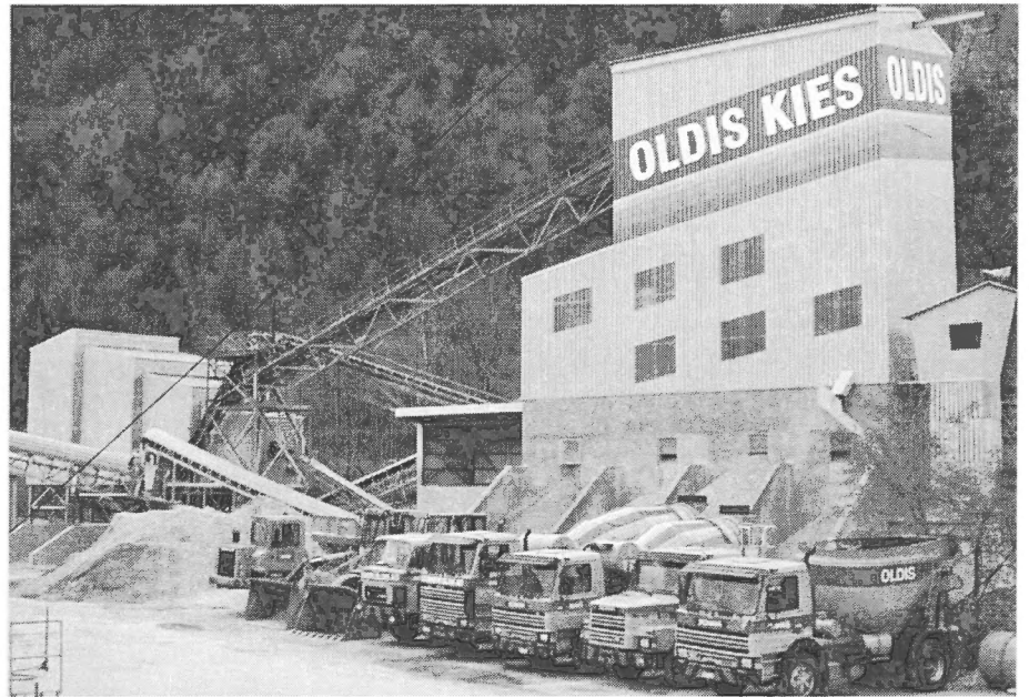
Rundkiesaufbereitung mit Werk- und Strassentransport-Fahrzeugen. Links: neue Splitaufbereitung.
