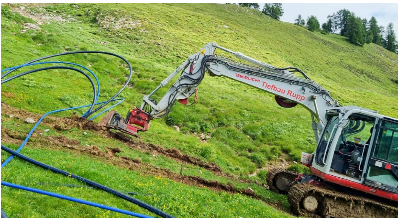
Leitungsbau Kabelpflug
