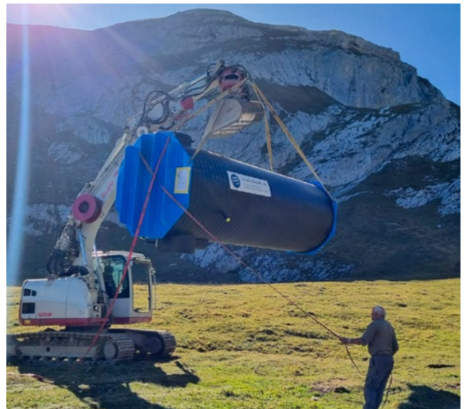
Einbau Reservoir
