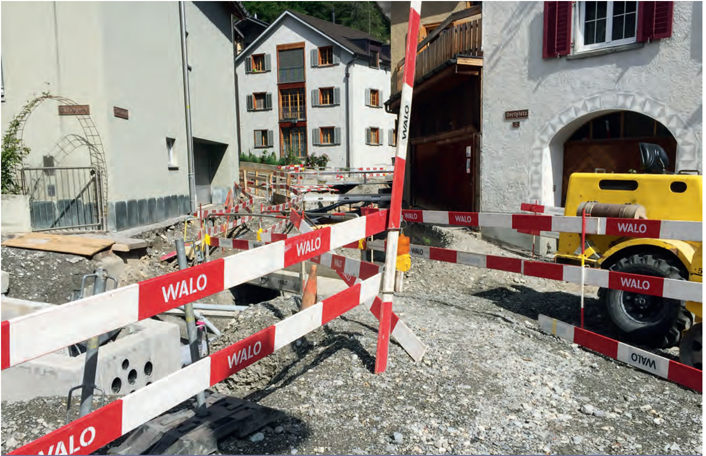
Umbruch andererseits auf dem Dorfplatz, wo die Strasse aufgerissen wird.
