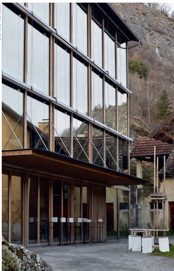
Das Atelierhaus Zumthor im Süesswinggel in Haldenstein.
