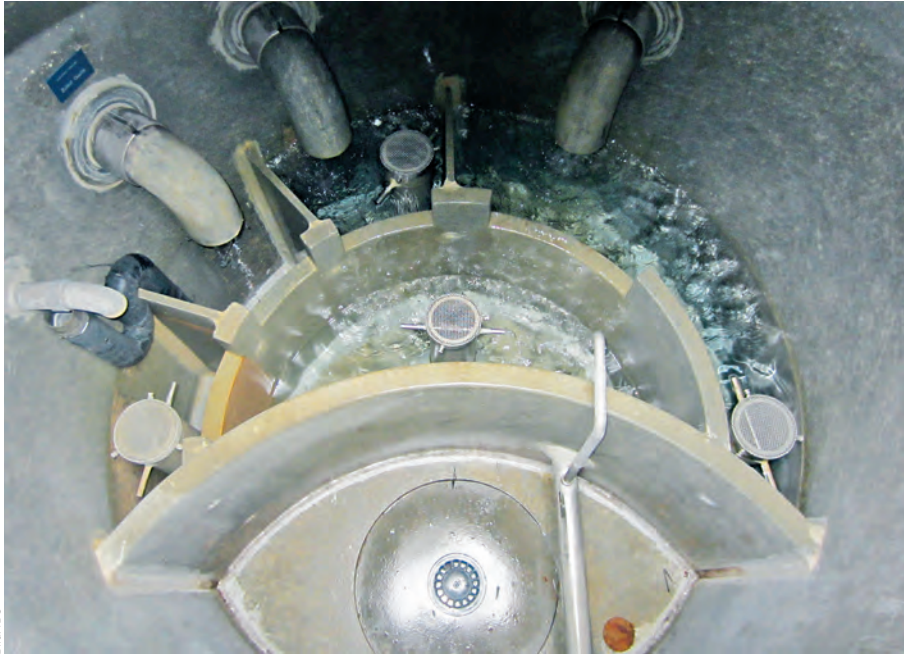
Sammelschacht Trögliwald mit Trockeneinstieg.
