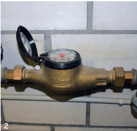
1 Im Trögliwald – Unterhaltsarbeiten durch die IBC. | 2 Eine Wasseruhr. | 3 Reservoirausgang Verteilleitung. Rot: Steuerung für Löschwasser.
