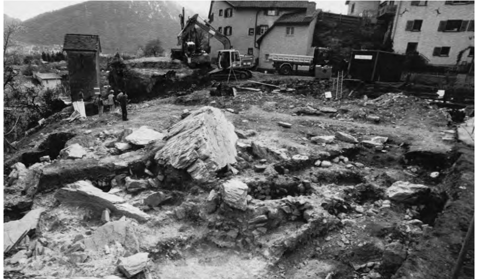
Das Baugelände nach dem Abbruch der bestehenden Gebäude auf dem «Stein». Im Vordergrund Grabungen des alten Friedhofs.
