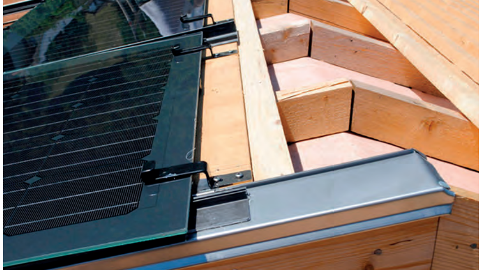
Montage-Detail für eine saubere Dachintegration im Firstbereich.
