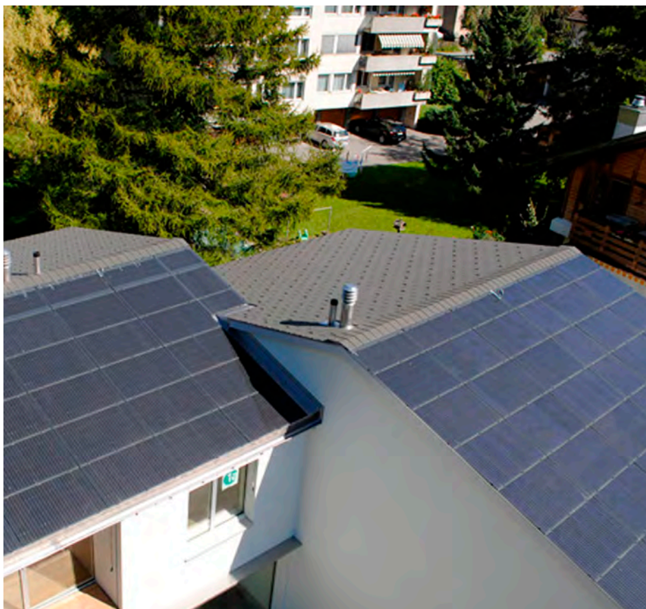
Perfekte Integration der Fotovoltaik-Panels ohne sichtbaren Rahmen und ohne Dachdurchdringungen. © Schweizer Solarpreis 2011/Solaragentur Schweiz
