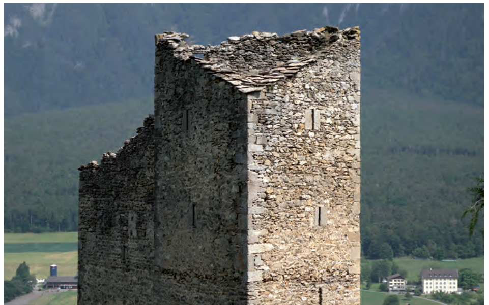
Abb. 8: Die auf den Mauerkronen erhaltenen Steinplatten des Turmdaches schützen diese noch heute.
