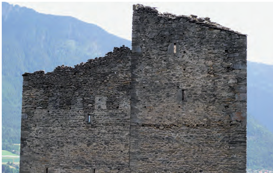
Abb. 10: Der nachträglich überbaute Zinnenkranz war einst der oberste Abschluss des Palas.
