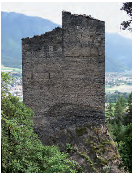
Abb. 9: Die aufgelösten Mauerkronen über der Nordmauer.
