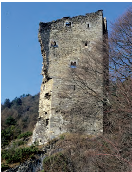
Abb. 11: Die aufgelösten Mauerkronen über der Nordostmauer
