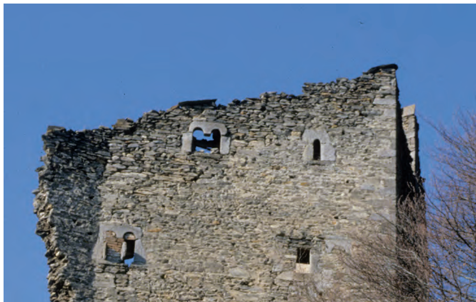
Abb. 12: Zwei auf der Mauerkrone liegende Steinplatten dokumentieren die jüngste Dachform
