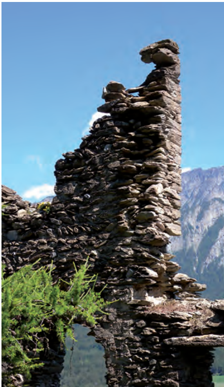
Abb. 19: Das linke Ohr der «Katzenburg» droht zu verstürzen.
