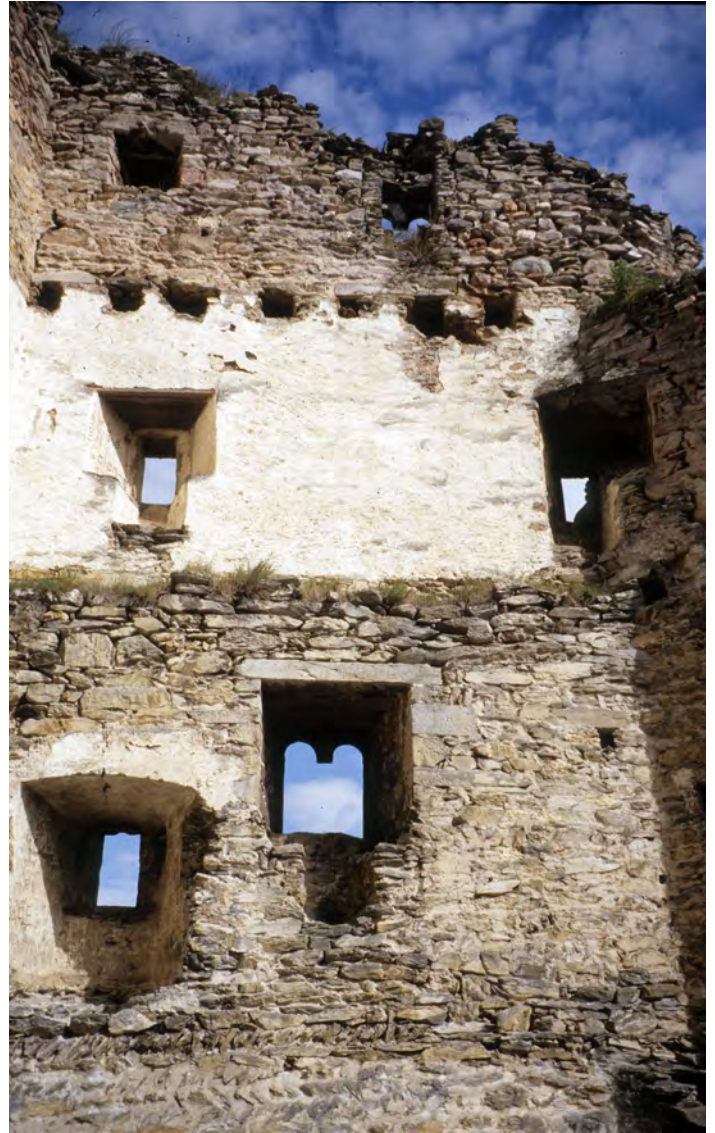
Abb. 14: Die erhaltenen Innenverputze dokumentieren die Raumeinteilung im Palas
