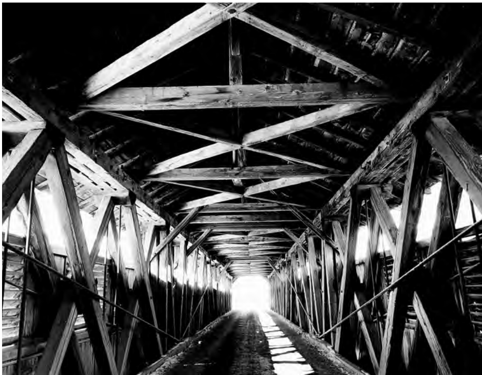
Innenansicht der Holzbrücke nach 1934.
