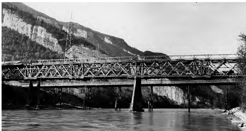
Abbruch der gedeckten Holzbrücke.
