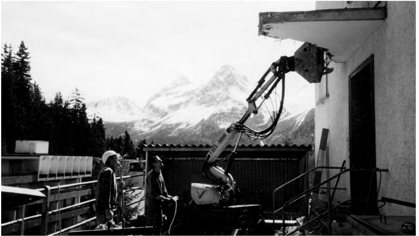
Abbruchroboter in Aktion
