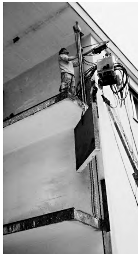
In luftiger Höhe
