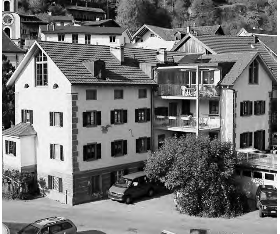
Der «Adler» nach dem Umbau.
